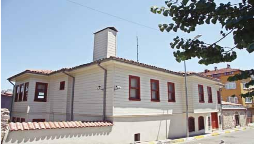
Resim 4- Sertarikzade Tekkesi ve Türbesi restorasyondan sonra. (Sertarikzade Tekkesi-Eyüp Belediyesi-2013)
