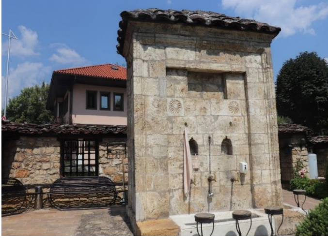
Resim 11: Alaca Camii Bahçesi Çeşme
